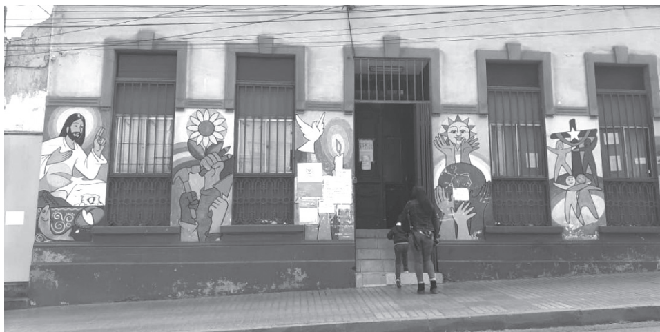
Fotografía del edificio INFOCA
